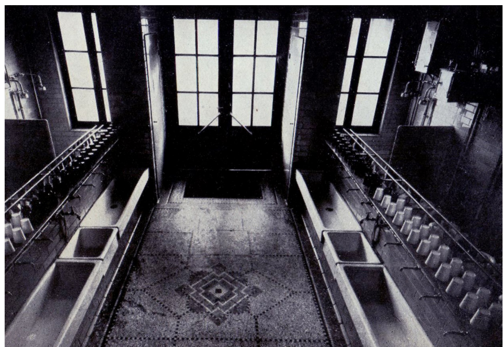
Salle d'eau et lavabos de l'école maternelle du Breucq, 1935
